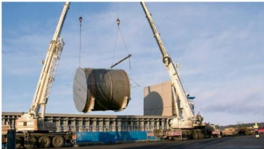
Titaanista tehty säiliö painoi vain 10 000 kiloa ja lastattaessa tuuli heilutteli sitä. Kaikki sujui lopulta hyvin. KUVA: JORMA HAVULA
