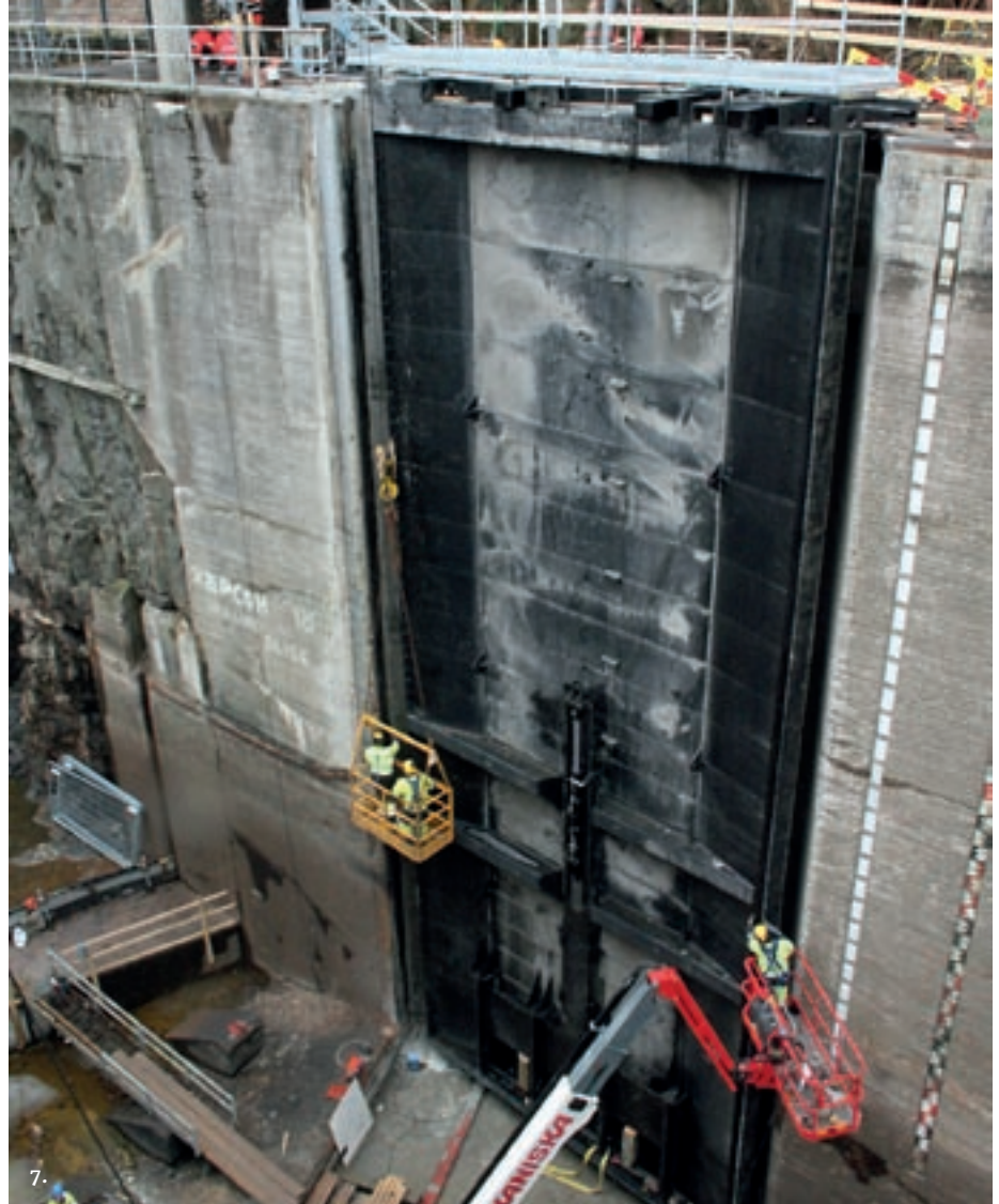
Kuva 6: Idänpuoleinen porttipuolisko on lännenpuoleisen puoliskon tapaan V:n mallinen. Kun portti on kiinni, se muodostaa loivan U:n mallisen rakenteen. Muoto valittiin tällaiseksi, jotta kiertymät eivät riko kumilaakereita. Portti on hitsattu teräslevyistä. Vain kävelysillassa on putkipalkkeja.
