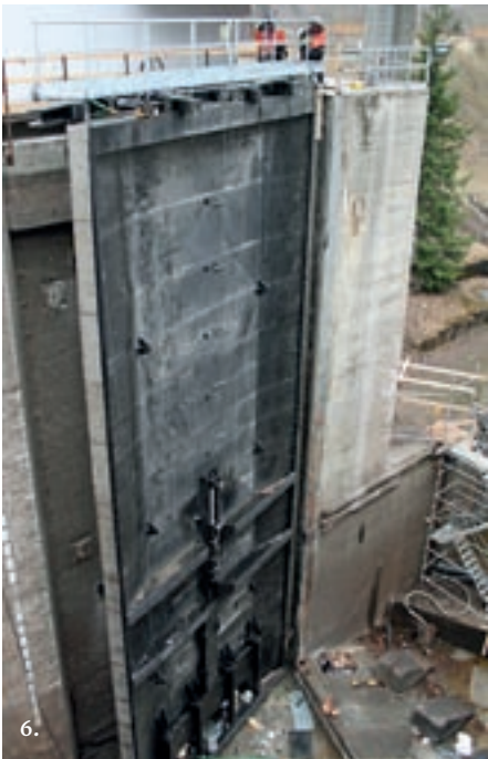
Kuva 6: Idänpuoleinen porttipuolisko on lännenpuoleisen puoliskon tapaan V:n mallinen. Kun portti on kiinni, se muodostaa loivan U:n mallisen rakenteen. Muoto valittiin tällaiseksi, jotta kiertymät eivät riko kumilaakereita. Portti on hitsattu teräslevyistä. Vain kävelysillassa on putkipalkkeja.
